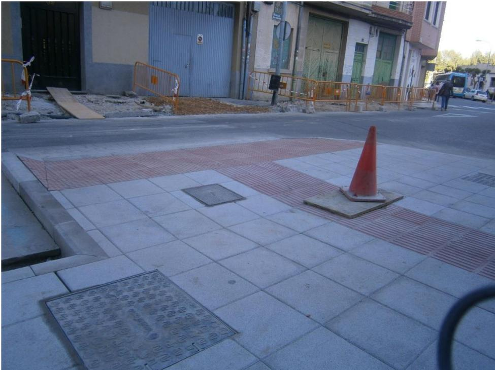
En esta calle, como se puede observar en la foto, el vado se ha realizado a criterio del constructor, arquitecto...: pendiente totalmente cubierta de pavimento de botones (1,10 m) y pavimento direccional de 90 de ancho ( 3 baldosas de 30x30) por falta de existencias de baldosas de 40 x40 ó 20 x20.
